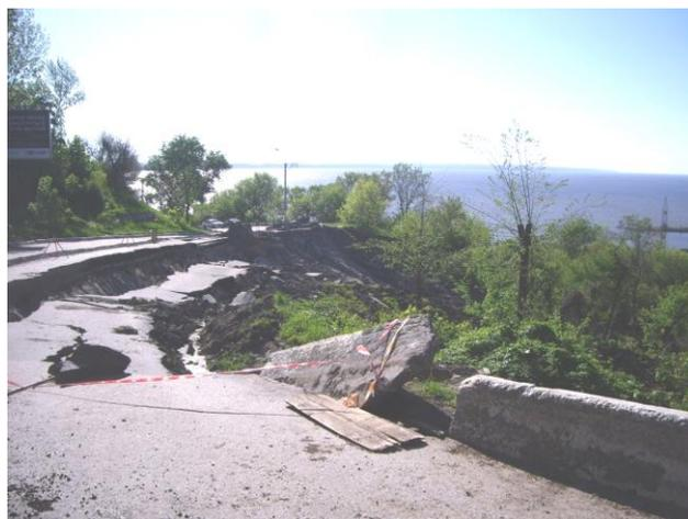
Рис.1. Сползание полотна дороги в г. Ульяновск из-за неэффективной работы дренажа и повышенной вибрации от прохождения железнодорожного транспорта и большегрузных автомобилей
